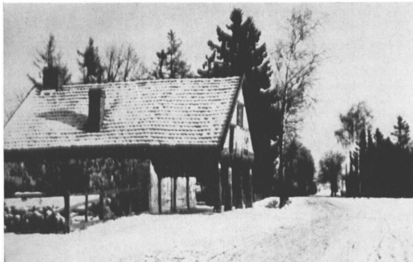
Vorhallenbauweise, Schmiede in Starkenberg mit Giebellaube
