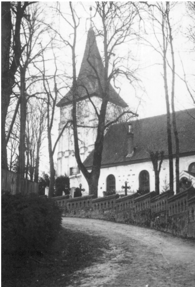
← Die Auffahrt zur Goldbacher Kirche. Sehr gut ist die bergansteigende, versetzte Kirchhofsmauer zu erkennen. Die Ziegelsteine dieser Mauer wurden von der Karpauer Ziegelei geliefert.
