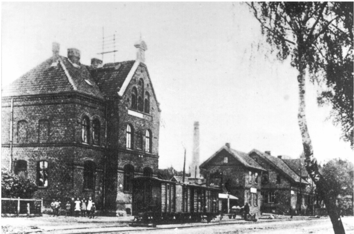
Das Goldbacher Postgebäude mit der Kleinbahnstation, die Werkstatt von Schuhmachermeister Sachs und die Genossenschaftsmolkerei mit Schornstein.
