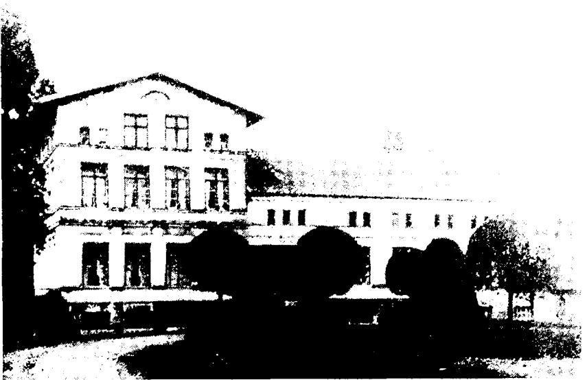
Das Gutshaus Miguschen
