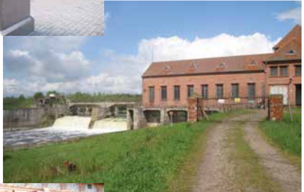
Sperwerk mit Kraftwerk an der Alle aus Deutscher Zeit.
