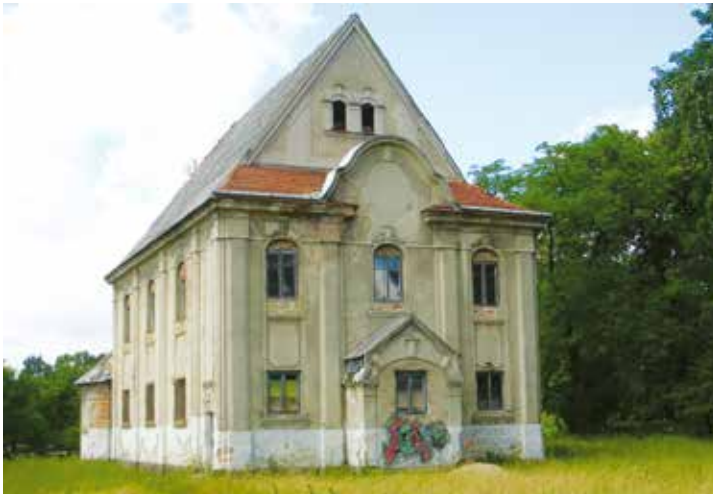
Die katholische Kirche in Wehlau kurz vor der Renovierung
