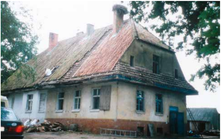
Das Schleusenwärterhaus im Sommer 2001
