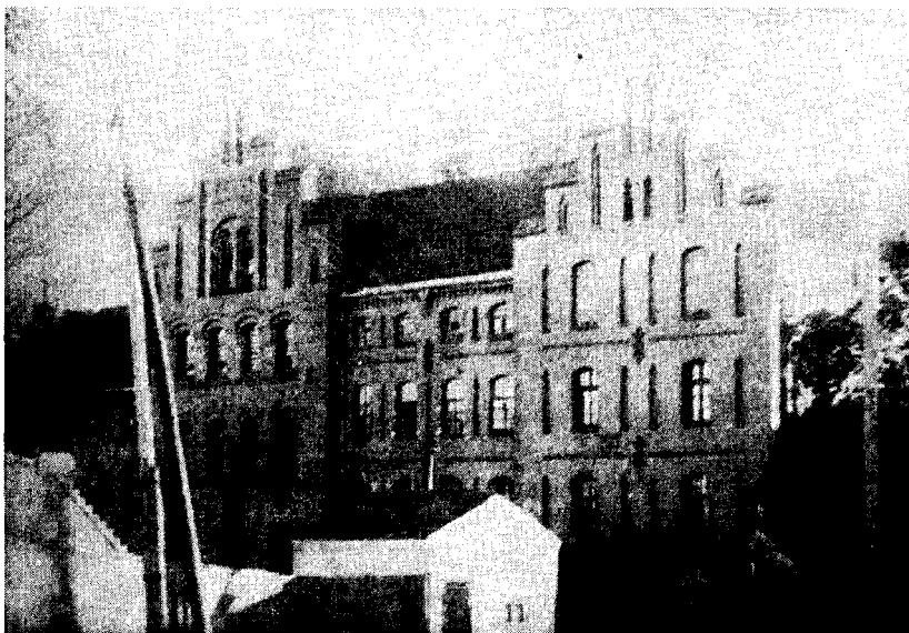
So sieht heute der Eingang zur Besserungsanstalt aus!
