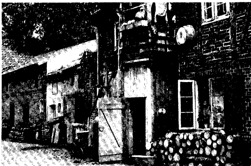
Oben: Der Flinsenwinkel, eine idyllische Ecke in Wehlau.
