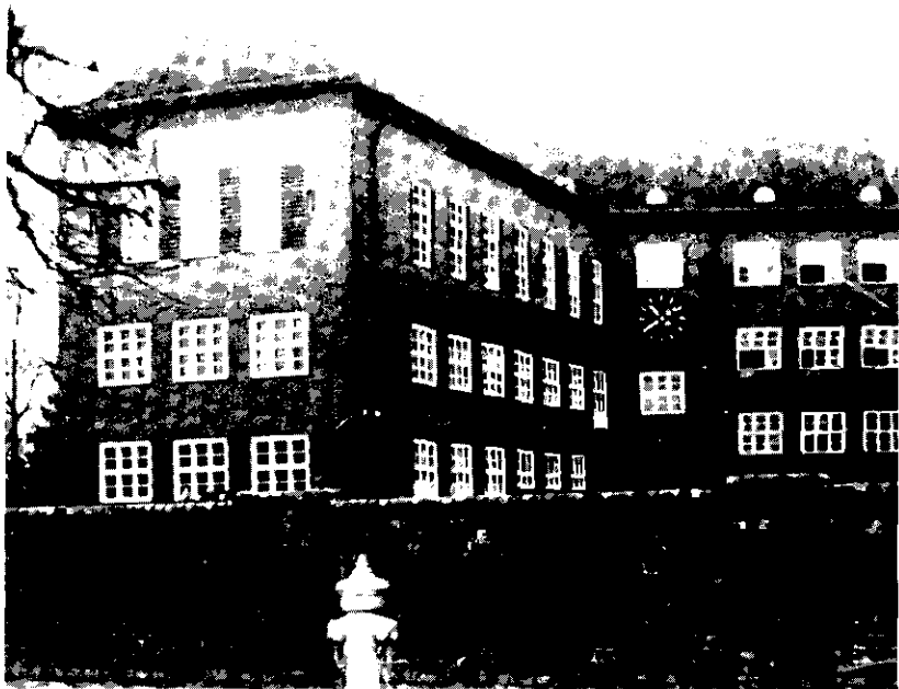
Neue Schule in Wehlau in der Richardtstraße.
