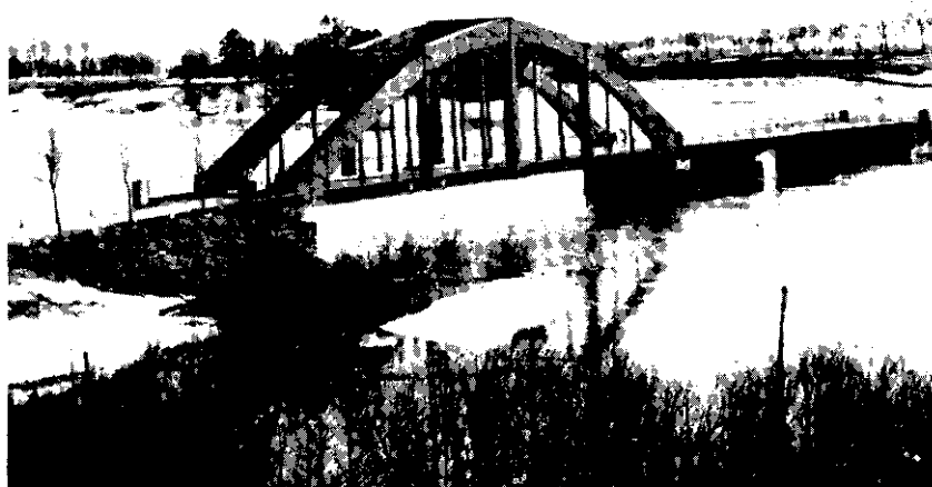
Hindenburgbrücke bei Leißienens. Die Alle führt Hochwasser.
