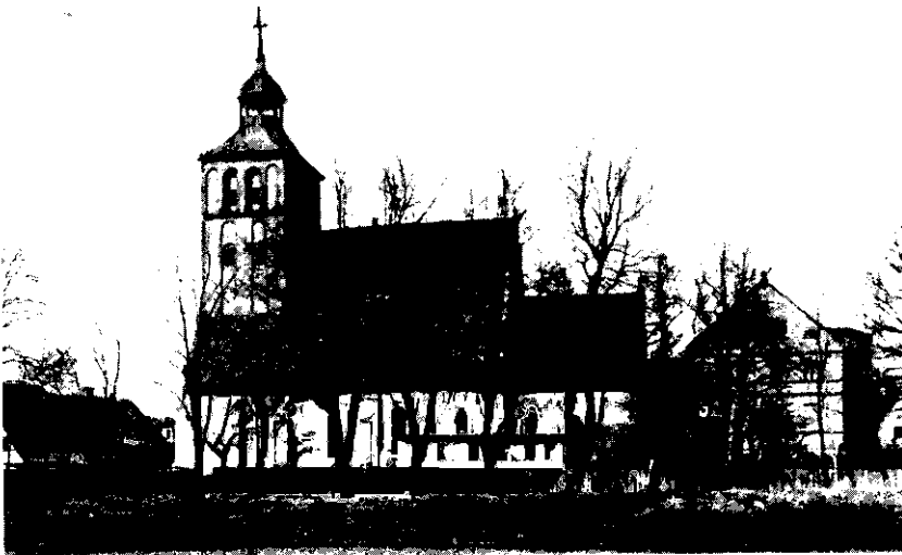
Unten: Wehlau — Kirche, Südseite.
