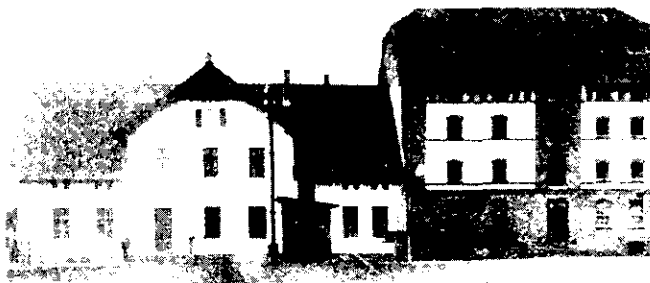
Das alte Beamtenhaus mit Speicher und Brennerei
