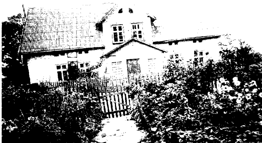
Wohnhaus Fr. W. Neumann mit von den Russen angebautem Vorbau
