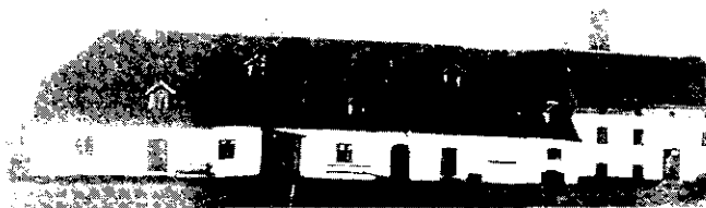
Das Beamtenhaus vor dem Umbau auf der Domäne Kleinhof
