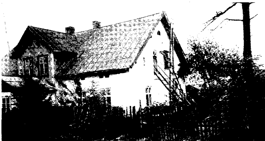
Bieberswalde 1991. Nordgiebel des Hauses von Fr. W. Neumann. Der Treppenaufgang im Innern des Hauses ist zugemauert, das Dachgeschoß wird außen über Leitern erreicht
