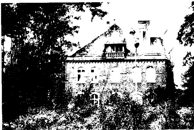
Das Wasserbauamt in Tapiau 1995 Foto: M. Garrn
