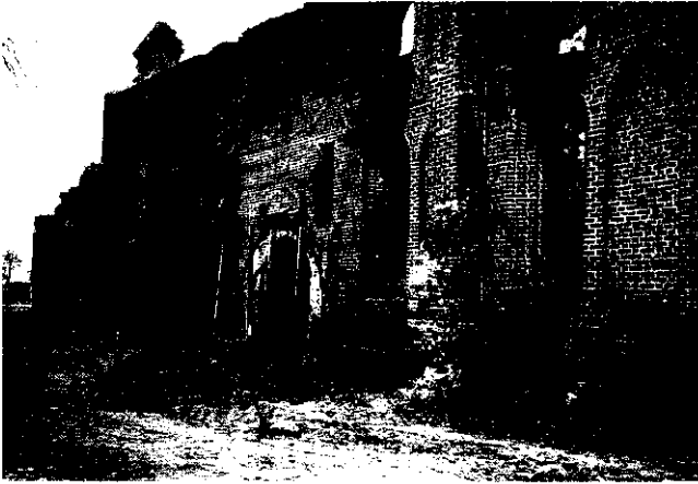
Auch das Äußere der Kirche wird freigelegt. Nord- seite (Marktseite) von St. Jacobi 1995. (Foto. H. Till)
