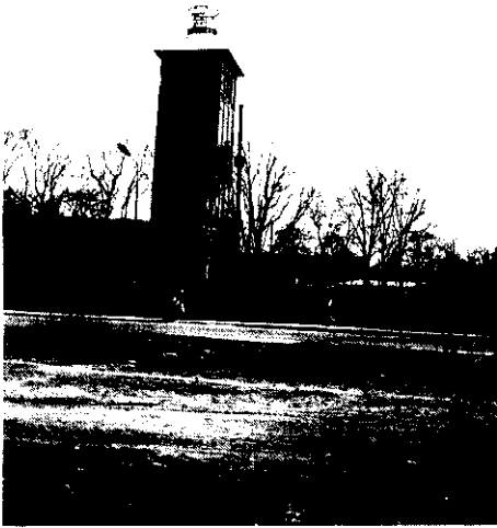
Der Turm ist aufgemauert, das Dach gedeckt, das Ge- rüst für die Laterne aufge- setzt. April 1996. (Foto: H. Breiksch)
