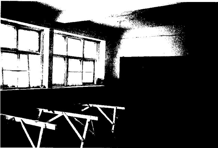
(Rechter) Innenraum der Schule Kapkeim 1991. Die Fenster stammen noch aus früherer Zeit, die Schule macht einen heruntergekommenen Eindruck. (Foto: G. Adam)
