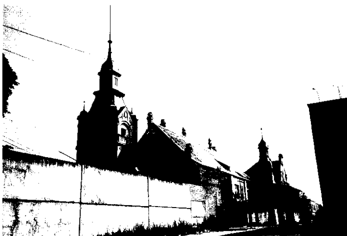
Schloß Kap- keim Südsei- te. Eingang zugemauert, die ganze Front ver- baut. (Foto: G. Adam)
