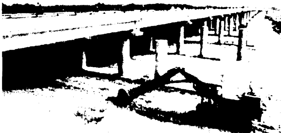
Die neu errichtete zweispurige Brücke bei Tapiau/Gwardejsk (Foto: Königsberger Express)
