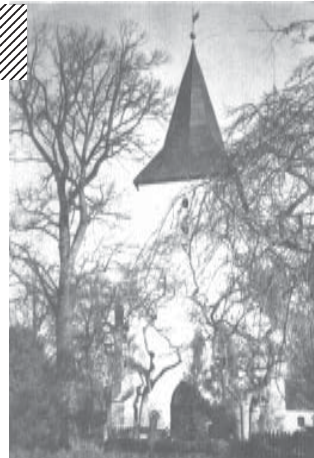
Ev. Pfarrkirche zu Petersdorf
