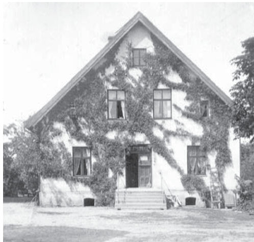
028-0016 Das Wohnhaus von Bürgermeister August Neumann in Groß Keylau
