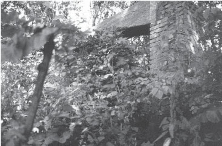
111-1119 Mauerreste des ehemaligen Sägewerks, 1997
