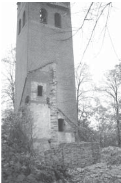
Der Turm der Schirrauer Kirche. Davor aufgeschichtete Ziegel zur Abholung bereit.
