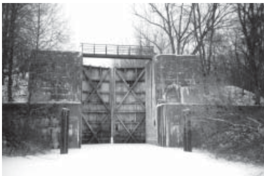
001-1103 Die zweite Kanalschleuse
