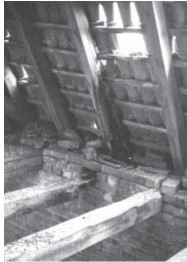
001-1108 Balken und das Dach
