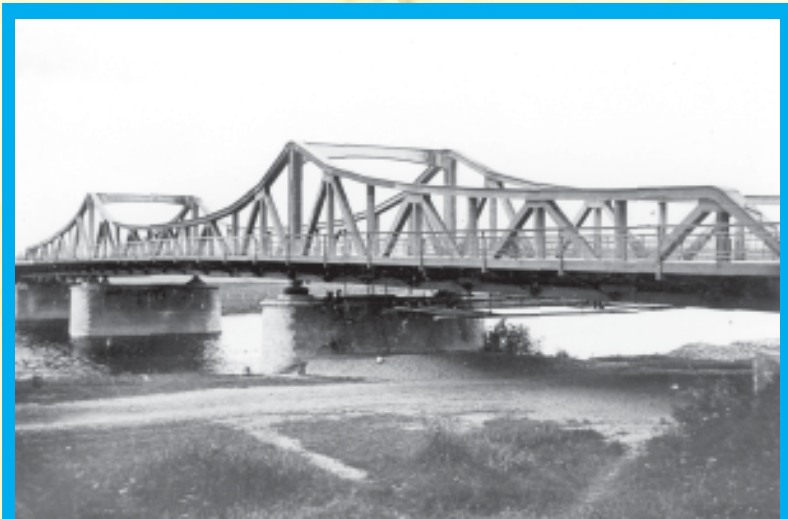
Die neue Pregelbrücke
