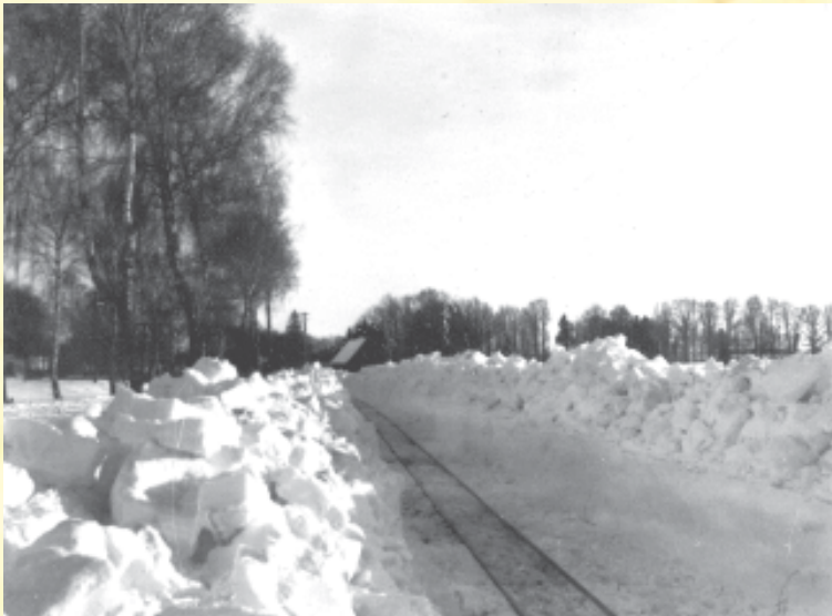
Kleinbahnstrecke im Kreis Wehlau im tiefen Winter
