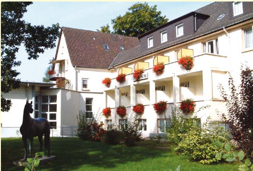
Das Ostheim in Bad Pyrmont - Gartenansicht
