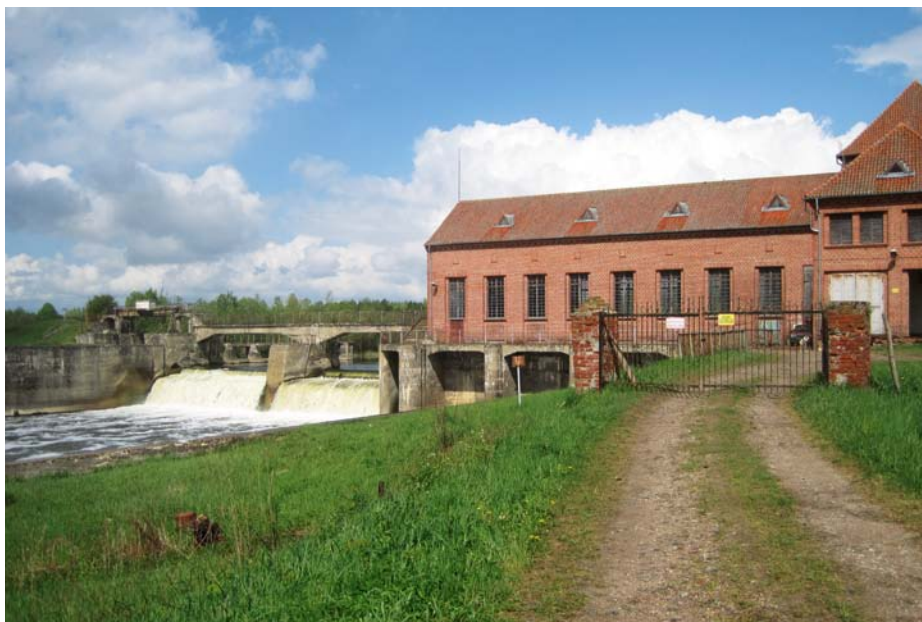
Wasserwerk an der Alle
