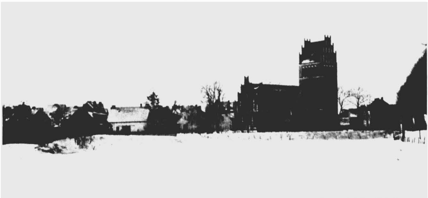
Die neue Kirche am Nordrand der Stadt, erbaut von Baurat Kurt Dieckert. Links davon das 2. und 1. Pfarrhaus (Widdem), rechts der Kirche das alte Krankenhaus, dann wurde es Wohnsitz des Bürgermeisters
