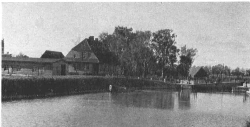
Kanalschleuse am Masurischen Kanal mit Schleusenhaus bei Allenburg
